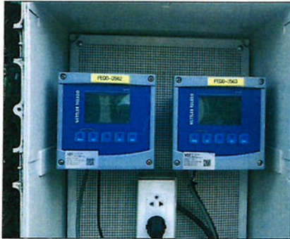
การติดตั้งระบบ pH online และ Conduct online ถังพักน้ำทิ้งจากระบบหล่อเย็นขนาด 50 ม3
