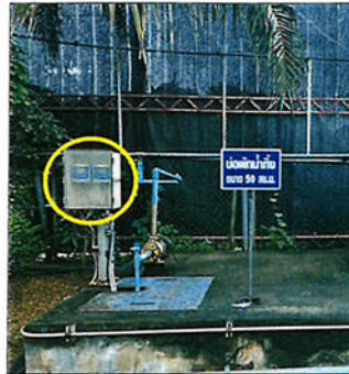
การติดตั้งระบบ pH online และ Conduct online ถังพักน้ำทิ้งจากระบบหล่อเย็นขนาด 50 ม3
